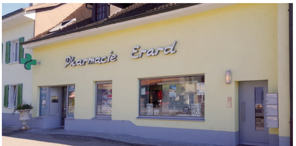
La façade a été rénovée en 2013. Photo: Alan Stalder.
